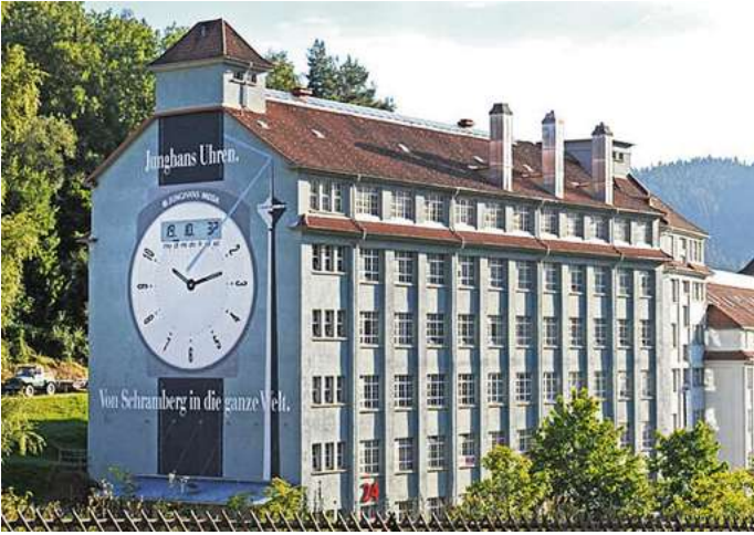
Das markante Gebäude 18 - 24 des Gewerbeparks „H.A.U.“ fällt in Schramberg bei der Fahrt in Richtung Talstadt sofort ins Auge.
