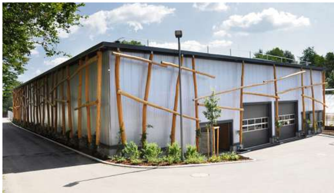
Das neue Lager- und Logistikzentrum „St. Georg“ am Vinzenz-von-Paul-Hospital.
